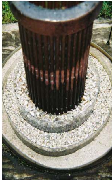
3-fach Kiesschüttung mit Steinzeug-Filterrohr
