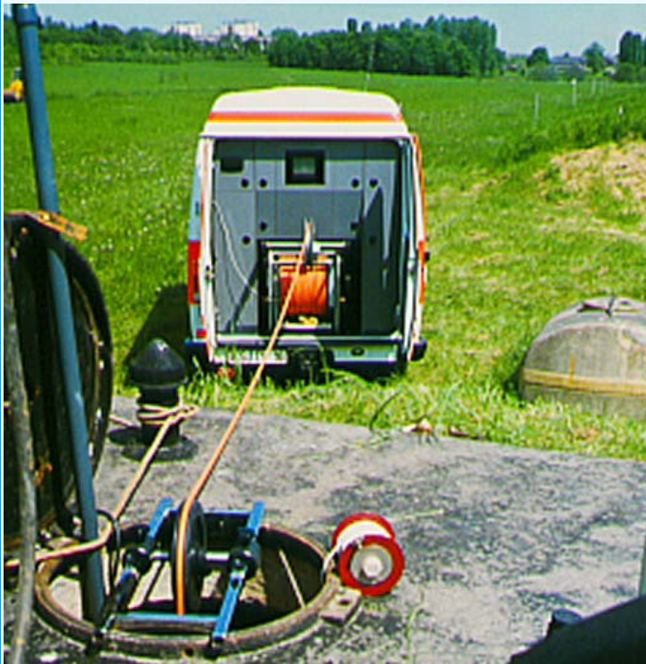
TV-Befahrung mit Spezial-Kameras
