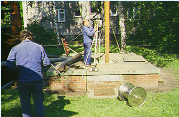
Vorbereitung TV-Kontroll- Untersuchung: Ziehen der Steigrohre mit Pumpe
