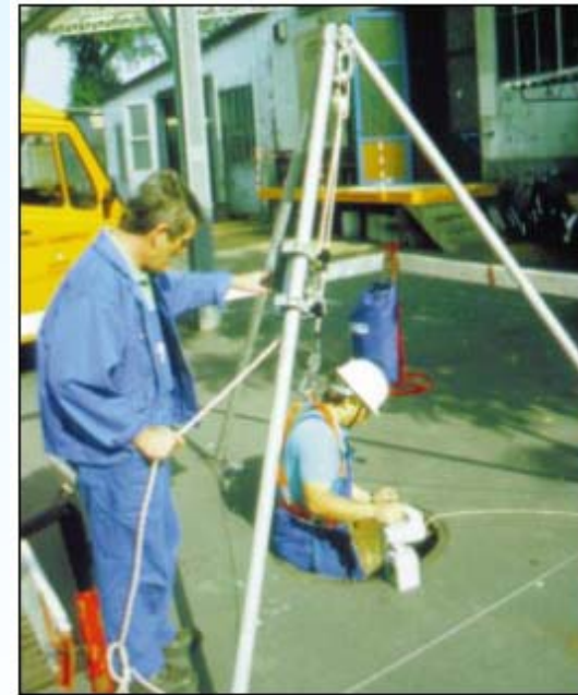
Aufsichtsführender über Tage
